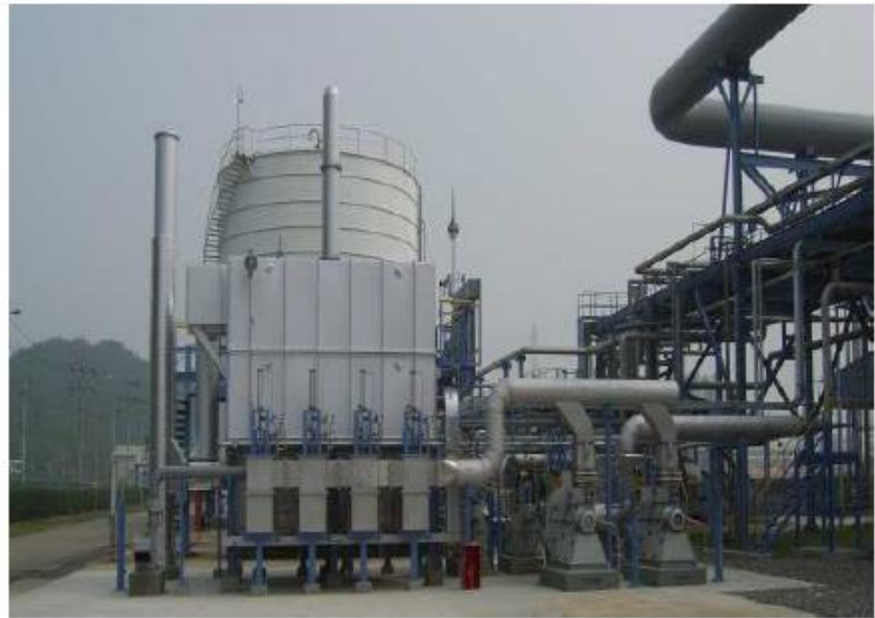
[RTO 시스템 현장설치 모습]
