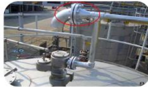
[증기 흐름 배관에 파열판 설치]
